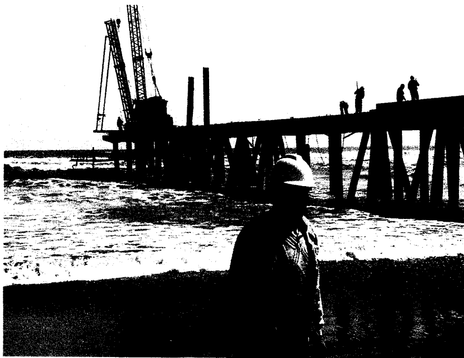
Foto: Otra vista de los pilotes que se vienen instalando desde el nivel del mar
