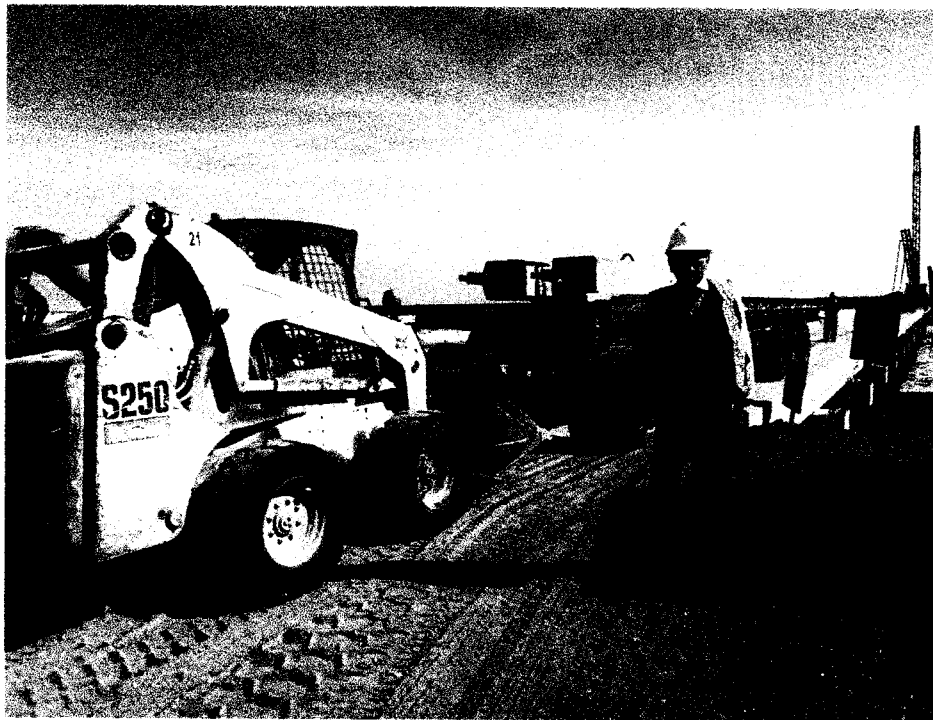
Foto: Equipo mecánico transportando pilotes al muelle
