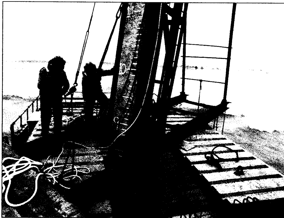
HINCADO DE PILOTES VERTICALES E INCLINADOS
