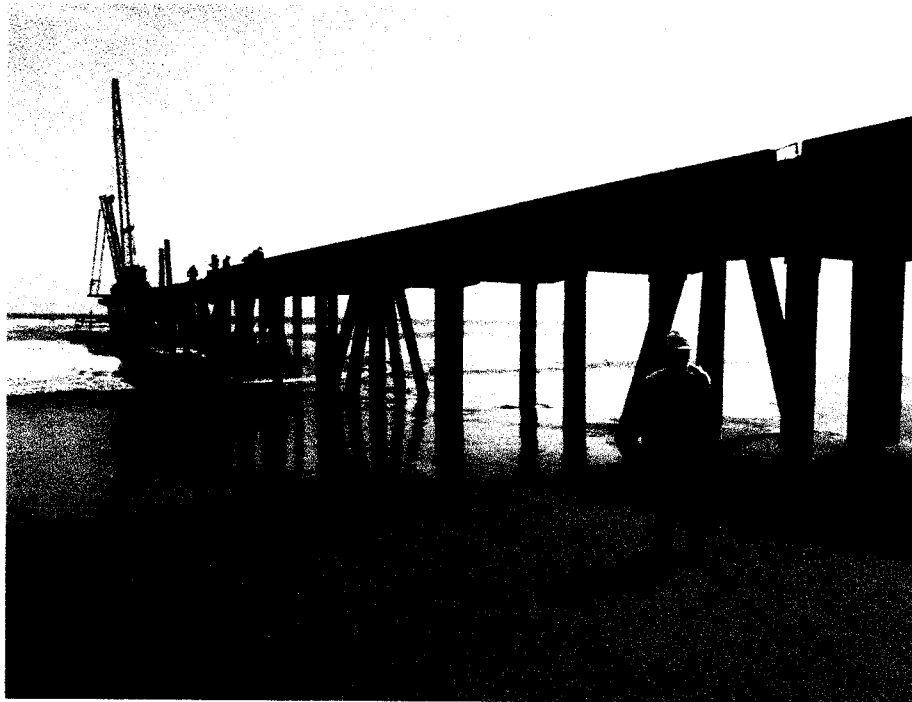
Foto: Vista inferior del muelle en donde se aprecia los pilotes que se vienen instalando
